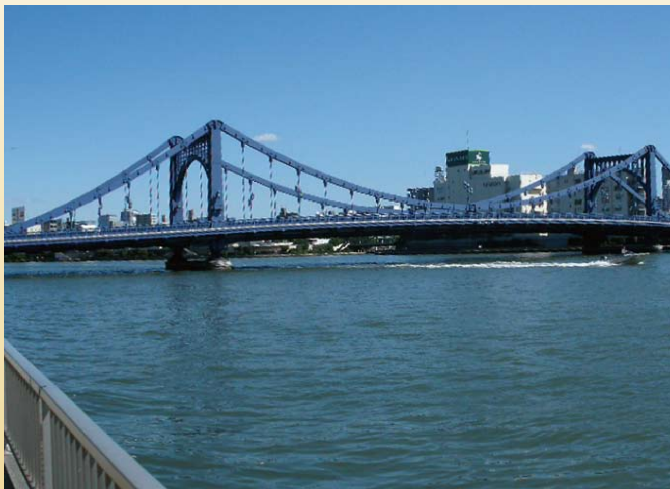
清洲橋（中央区の名所・旧跡）
